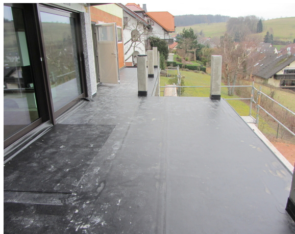
Der Systemaufbau besteht aus vier Schritten: Lose verlegte Drainagematte, stabiler Ausgleich mit Epoxidharzdrainageestrich und eine wasserfreie Verlegung der Platten mit anschließender Verfugung. (Foto: Ceresit Bautechnik)
