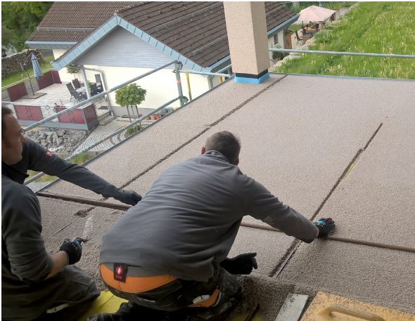
Verlegung und Glättung des Ceresit-Epoxidharzestrichs. (Foto: Ceresit)
